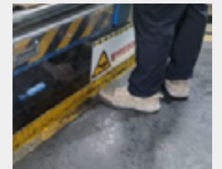
수직리프트 틈새에 아크릴 방벽 설치
