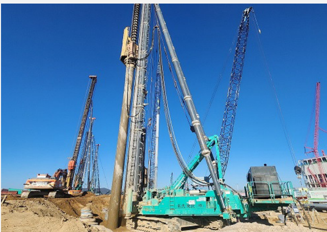
항타기 집중 살수장치
