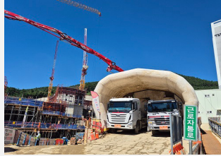
콘크리트 펌프카 에어방음벽
