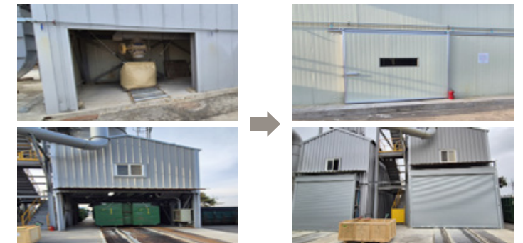
집진설비 분진 비산 방지 도어 설치
