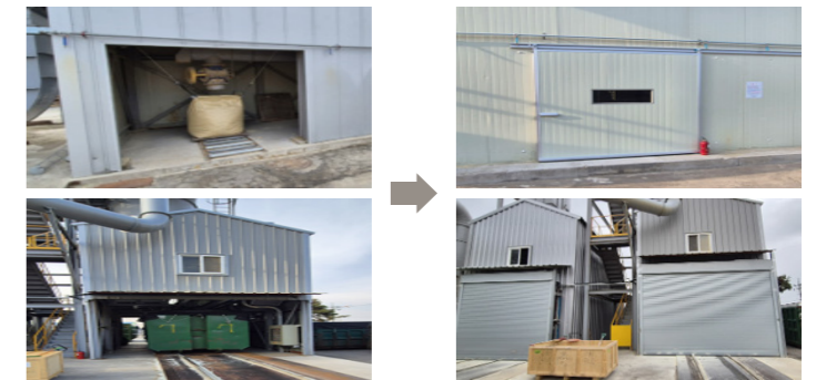
집진설비 분진 비산 방지 도어 설치
