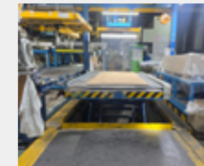
바닥과 수직리프트 틈새에 발 끼임
