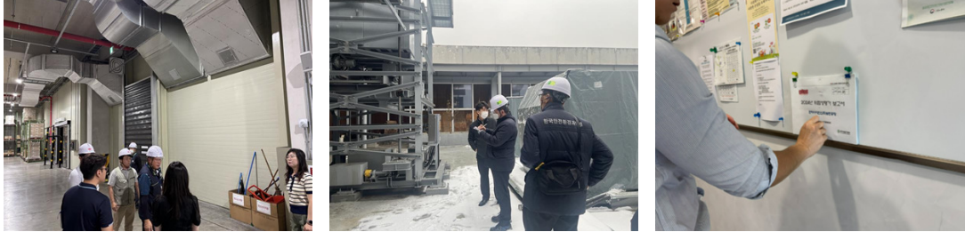
제3자 안전보건진단 및 본사주도 안전보건진단 현장
